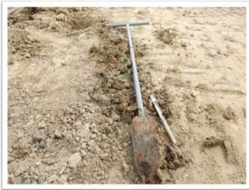
Afb.9. Grondboring voor noordelijk “dijkhoofd”, boorput b.
