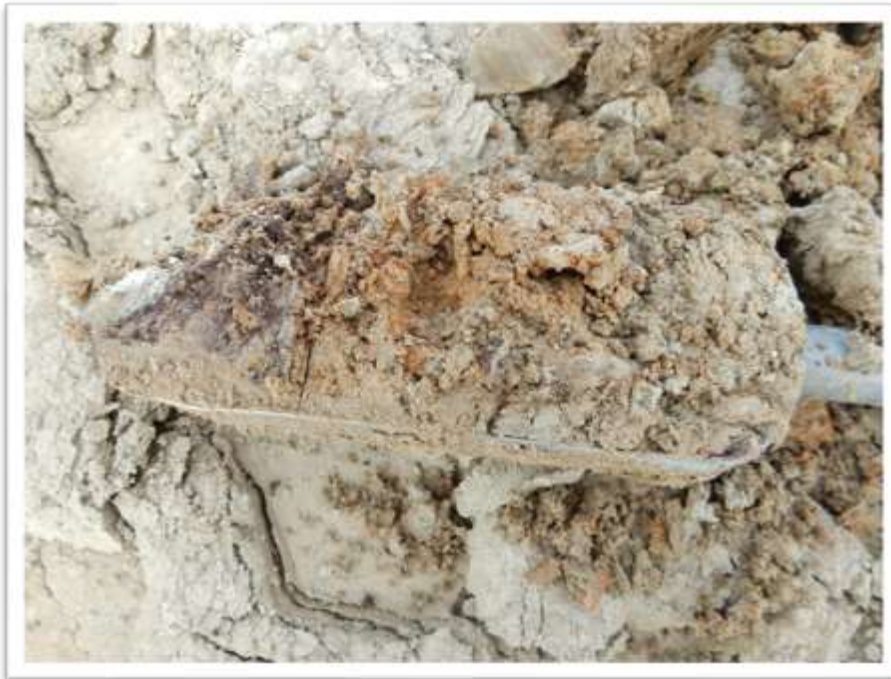
Afb.11. Grondboring voor het zuidelijke “dijkhoofd”, boorput d.
