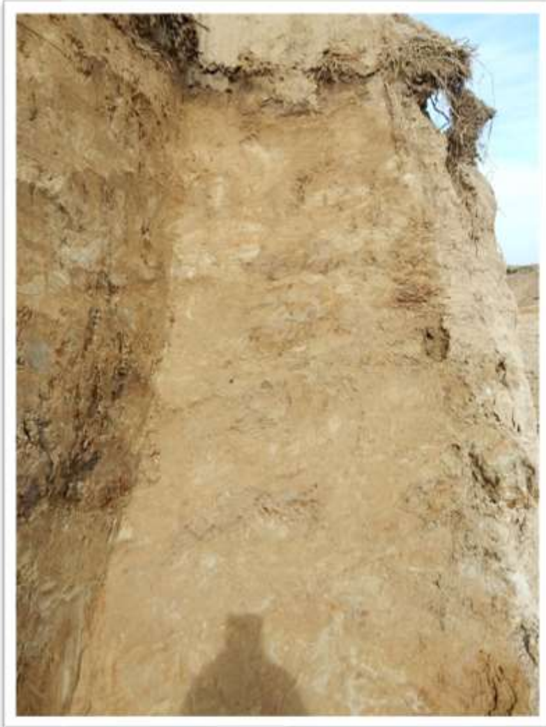
Afb.4. Ophooglagen in het dijkprofiel van het zuidelijke “dijkhoofd”, locatie 1.
