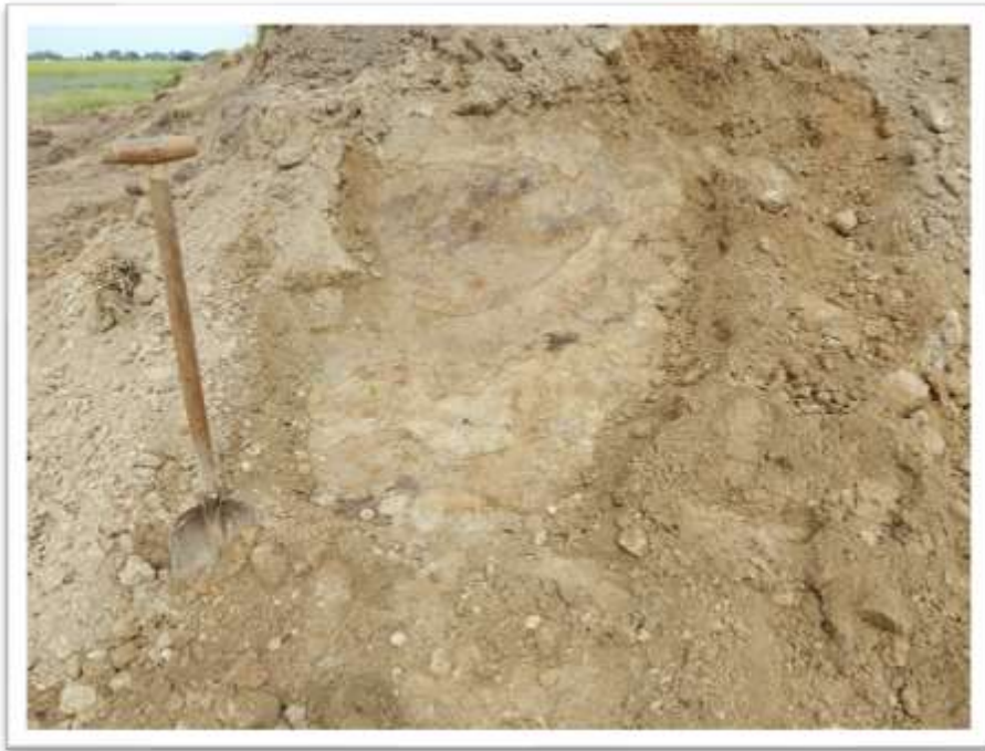
Afb.6. Ophooglagen in dijkprofiel van het noordelijk "dijkhoofd", locatie 5.
